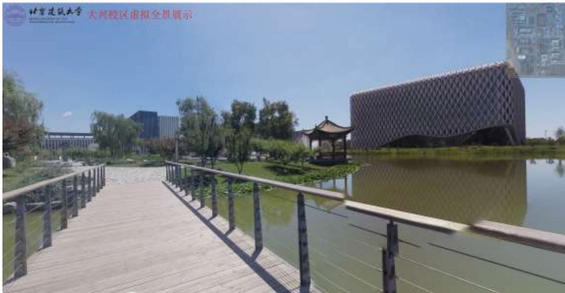
图 5-1-6 拟建桥梁东南向实景图
